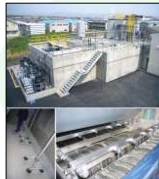
ニップンエンジニアリング(株)が 施工した廃水処理設備プラント
