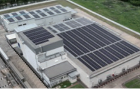
NIPPN Thailandの太陽光発電設備
