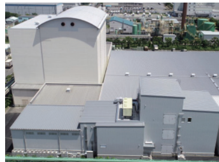
手前が2020年に竣工した福岡工場プレミックス工場
