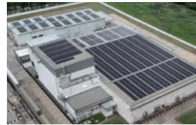
NIPPON Thailandの太陽光発電設備
